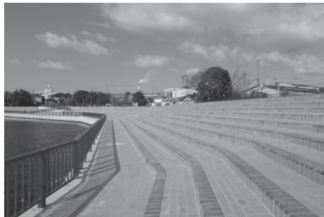
写真1：堺泉北港海岸堺市堺港旧港地区 南海トラフ巨大地震対策階段護岸部
