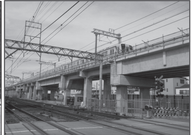
写真3：南海本線 連続立体交差事業(高石市)
