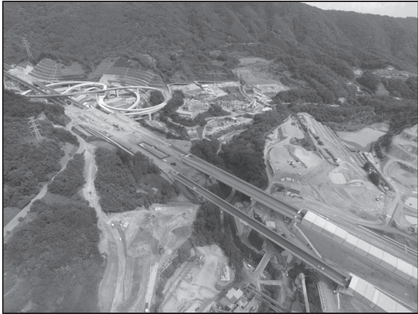
写真1：新名神高速道路箕面とどろみ IC アクセス道路(箕面市)
