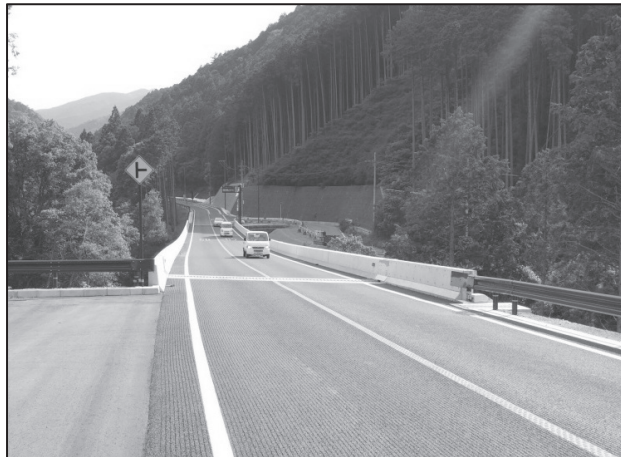
写真2：府県間道路 国道480号(和泉市)
