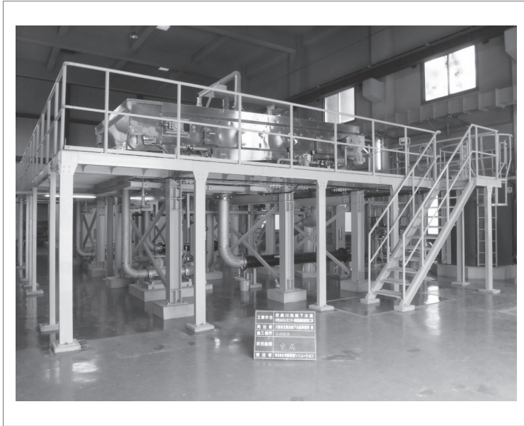
写真 1：中央水みらいセンター 濃縮機設備更新
