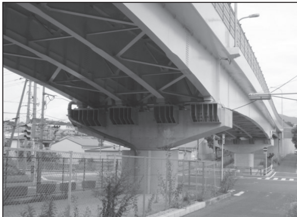
写真4：国道371号 加賀田跨道橋(耐震補強) (河内長野市)
