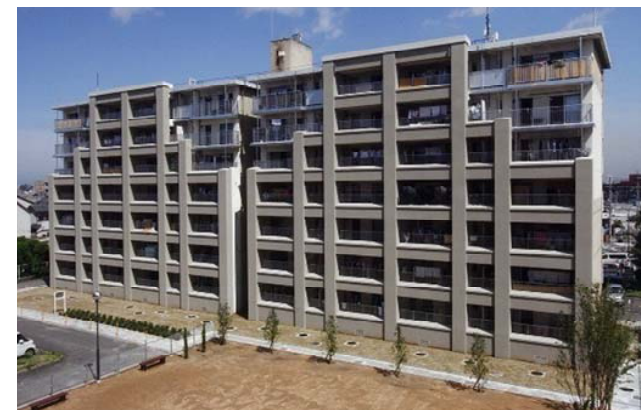
【耐震改修事業(アウトフレーム工法)】深井中町住宅
