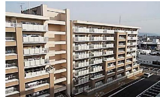
【耐震改修事業（アウトフレーム工法）】
