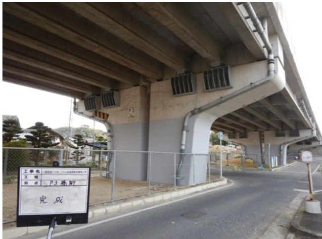
写真4：国道170号 三ヶ山高架橋(耐震補強) (貝塚市)
