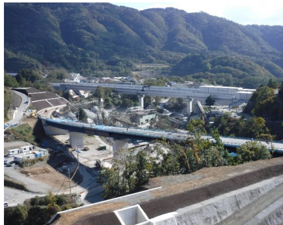
H30.11 上部架設状況
