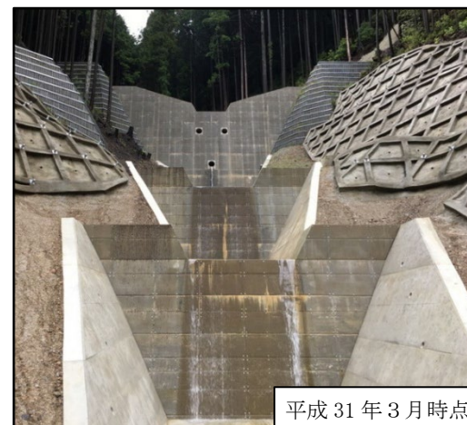
写真 4 : 父鬼川右第十八支川 通常砂防事業 (和泉市)
