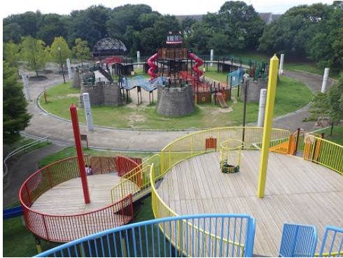
写真2：遊具改修（深北緑地 とりで広場）
