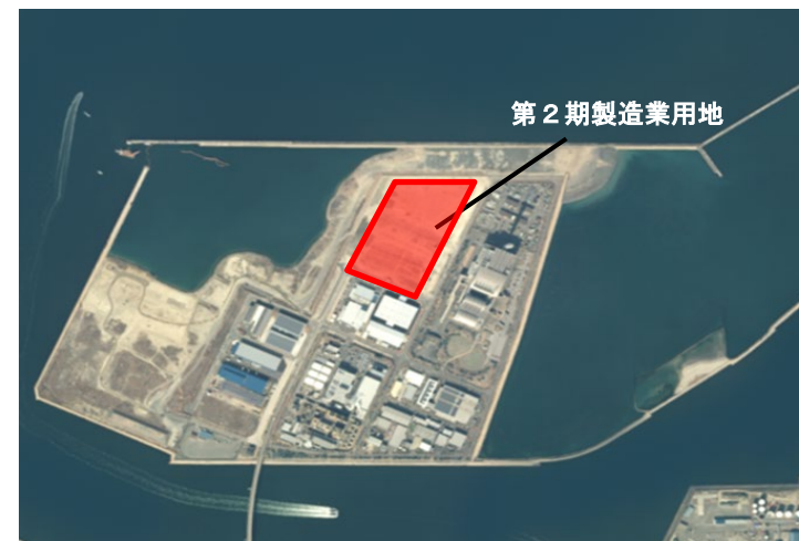
写真1：阪南港阪南2区整備事業（岸和田市）
