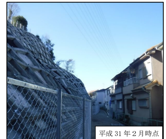
写真 5 : 喜多町 (1) 地区急傾斜地 災害関連事業 (河内長野市)
