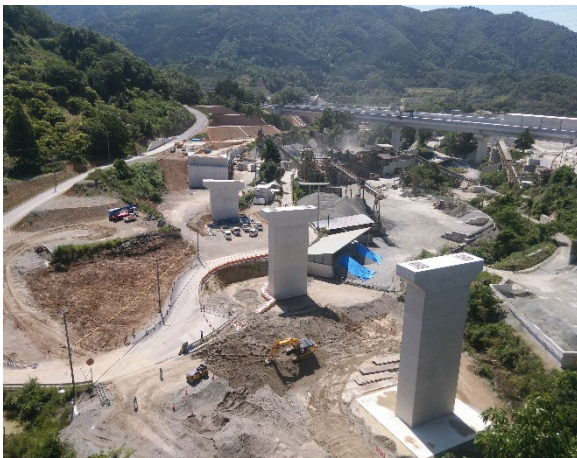
H30.6 下部設置状況
