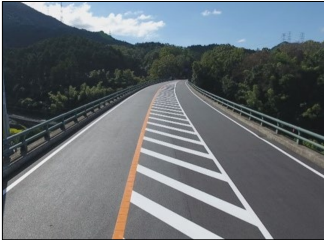
写真1：府県間道路 国道371号(河内長野市)
