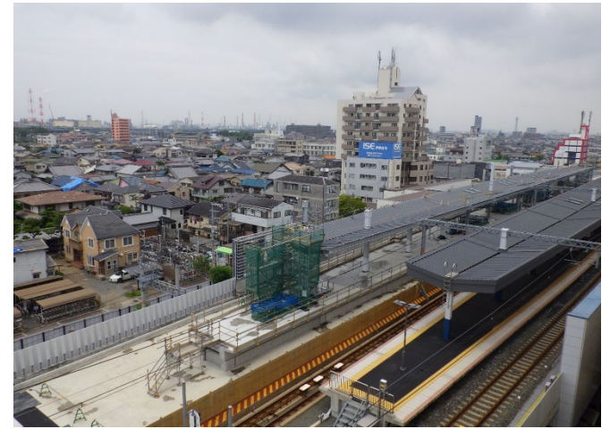
写真3：南海本線 連続立体交差事業(高石市)
