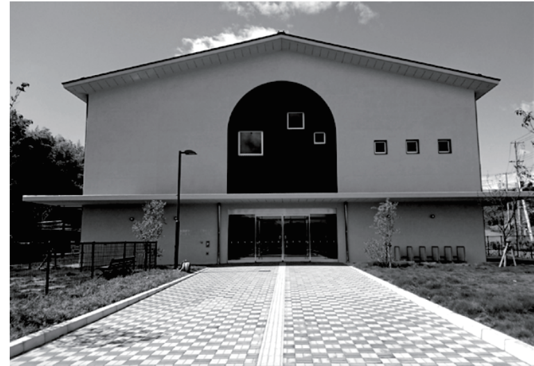
【大阪府動物愛護管理センター新築その他工事】
