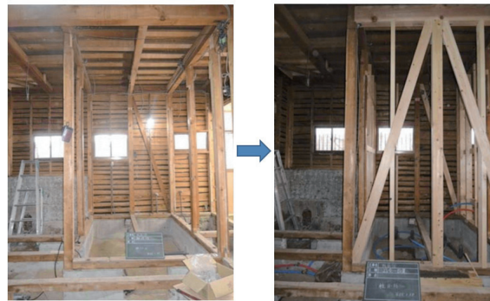
【耐震改修工事】
