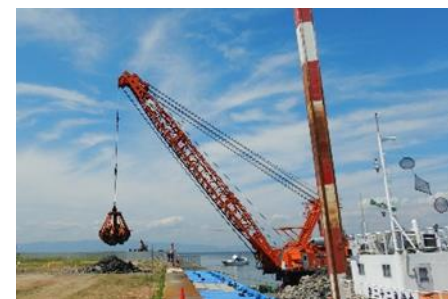
写真2：堺泉北港夕風第2号岸壁 整備状況(泉大津市)
