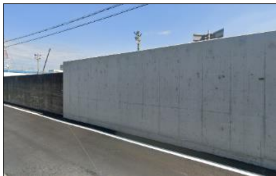
写真：堺泉北港海岸 堺新港地区【堺市】 (高潮対策)
