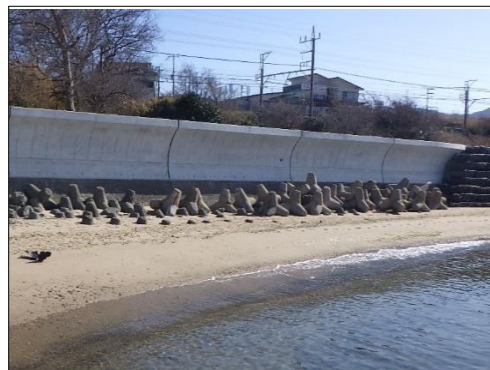
写真：泉州海岸 貝掛地区【阪南市】 (高潮対策)
