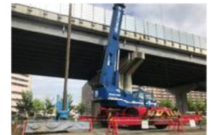
写真7：大阪モノレール延伸事業
