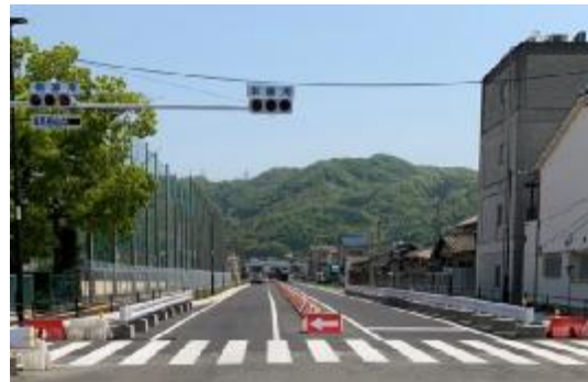
写真2：都市計画道路 大県本郷線（R3.3 供用）（柏原市）
