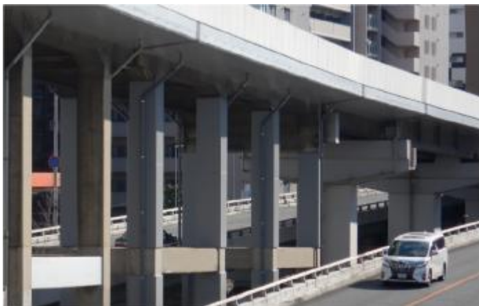
写真 1：鉄道耐震補強状況（北大阪急行南北線 国道 423 号並走部）
