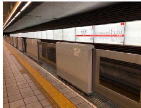
写真 2：可動式ホーム柵整備状況（Osaka Metro 御堂筋線 新大阪駅）
