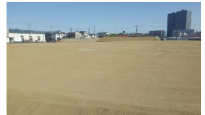
写真1：防災公園整備 (久宝寺緑地 避難広場 基盤整備状況)
