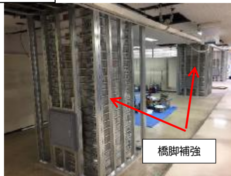
高架駅の耐震対策(橋脚補強)
