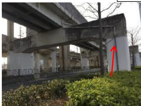
広域緊急交通路と並走する鉄道高架橋の耐震対策(橋脚補強)
