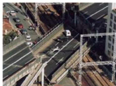
上部構造の落橋
