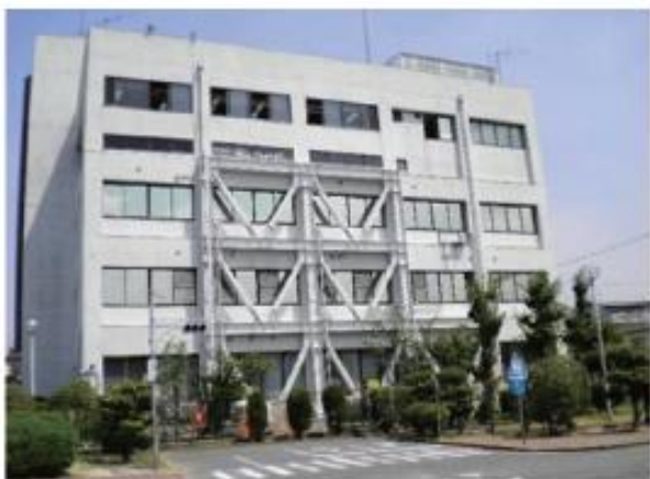
【警察署】門真警察署(外付鉄骨ブレース補強)
