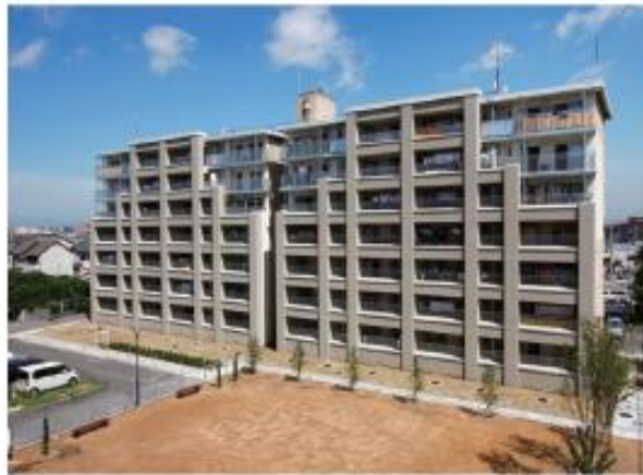
【府営住宅】深井中町住宅(Pca アウトフレーム工法)
