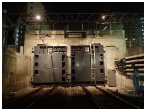
トンネル坑口の浸水対策 (止水扉の設置)
