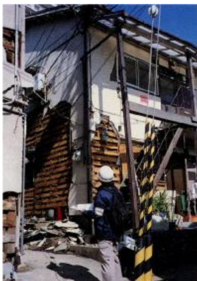
▲ 被災した建築物を調査する判定士 (出典：全国被災建築物応急危険度判定協議会 HP より)
