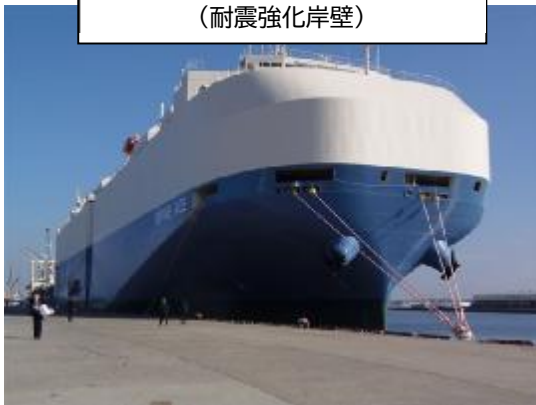
堺泉北 泉北 6 区 助松 9 号岸壁 (耐震強化岸壁)
