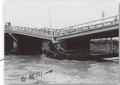
千歳橋の橋脚破損(茨木市戸伏町)
