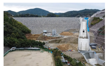
下流からダム堤体を望む
