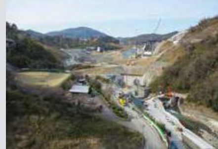
【基礎掘削～堤体盛立】
