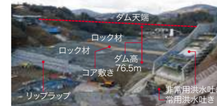
ダムサイト下流から上流を眺めたダム本体工事の状況
