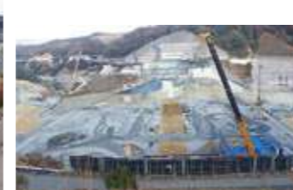
安威川ダム展望広場から眺めたダム本体工事の状況
