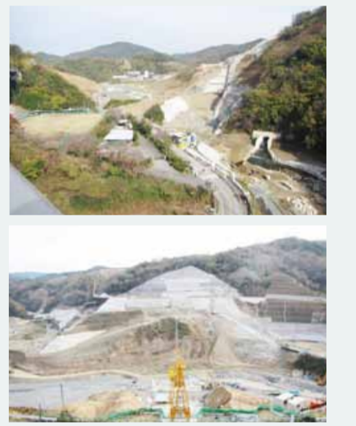
安威川ダム建設工事の進捗状況
