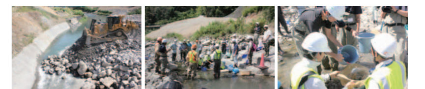
(左) 上流仮締め切りで川の流れをせき止めている様子 (中・右) 水生生物の保護・救出の様子
