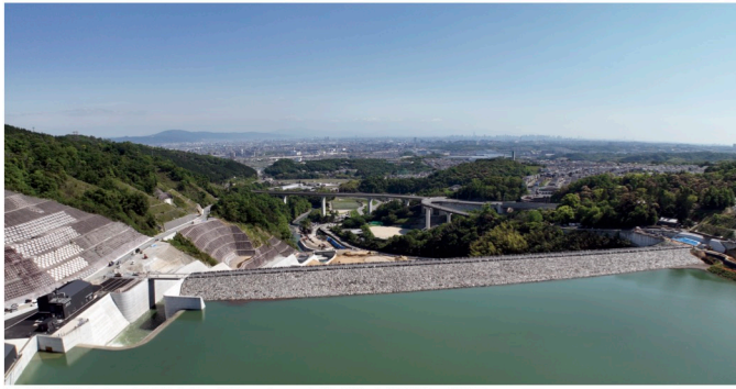
※ 試験湛水中の最高水位（サーチャージ水位）到達時の様子
