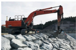
ICT(情報通信技術)重機による精度管理
