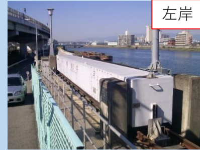
千船大橋防潮鉄扉
