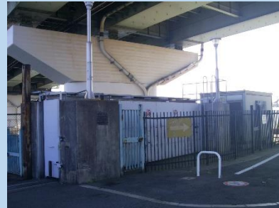
大和田船留鉄扉
