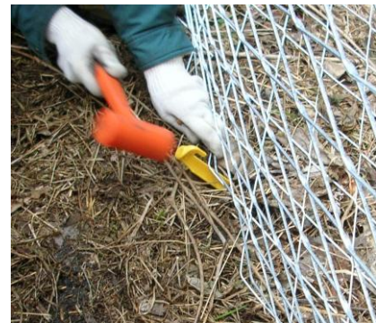
接地面へのペグの打ち込み
