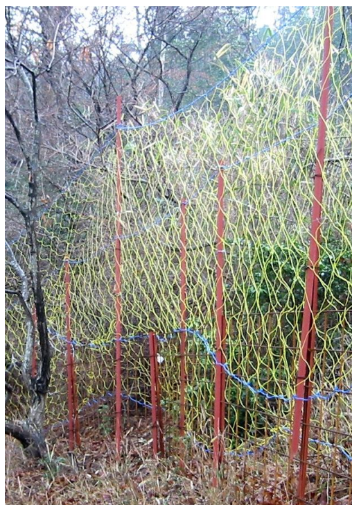
シカの飛び越え防止のため、ワイヤーメッシュの上部にネットを設置した柵
