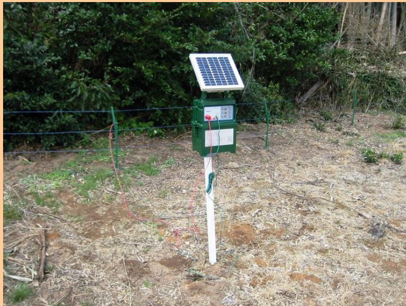
上：集落ぐるみでの金属柵の施工（茨木市）
