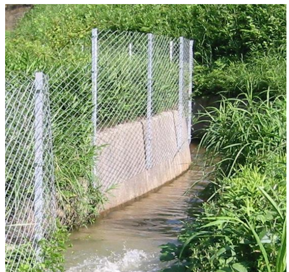
水路のコンクリート護岸に設置された金属柵
